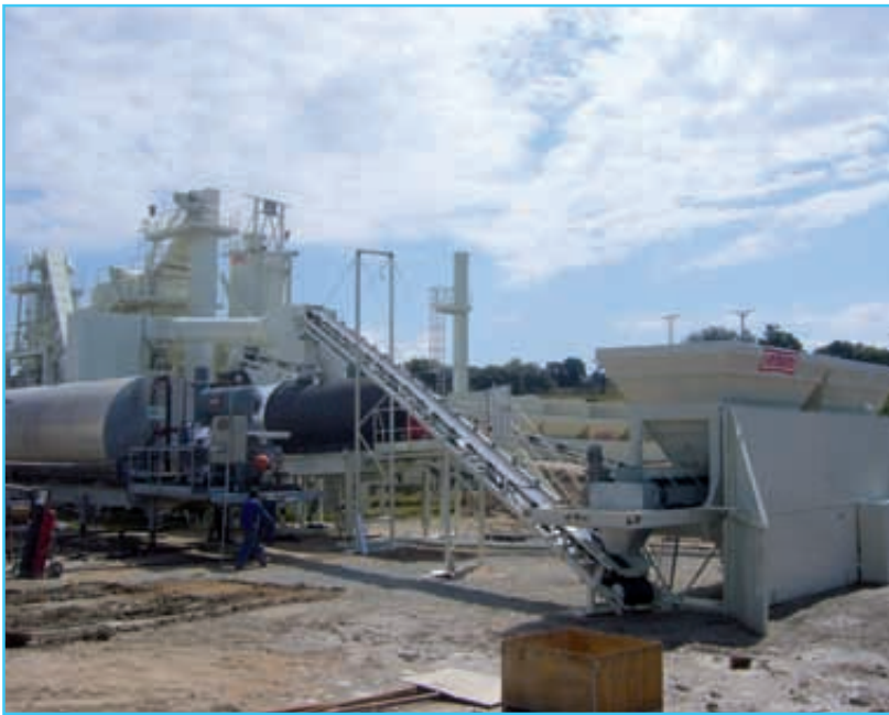
Foto 4. Integración del sistema de reciclado en una planta asfáltica UIM-200: Integración de las tolvas predosificadoras del sistema de reciclado con la planta asfáltica.
