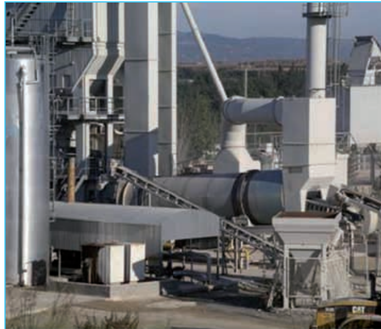
Foto 1. Planta discontinua con incorporación de materiales fresados a la salida del tambor secador.
