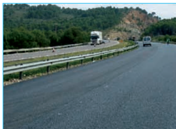
Foto 1. Detalle de firme fisurado antes y después del tratamiento con BMAP.
