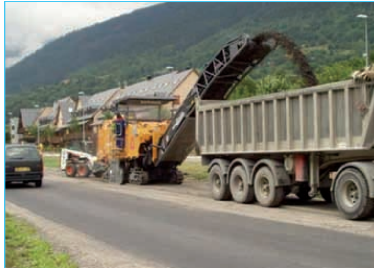
Foto 7. Fresado de materiales reutilizados en la misma obra de la que se han extraído. (CN-230, Valle de Arán, Lleida).
