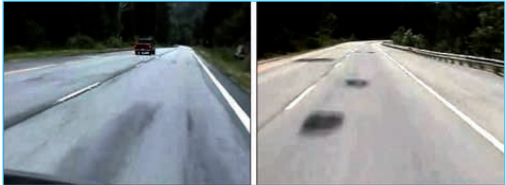
Foto 4. Ejemplos del efecto negativo de la segregación de las mezclas bituminosas en su durabilidad.
