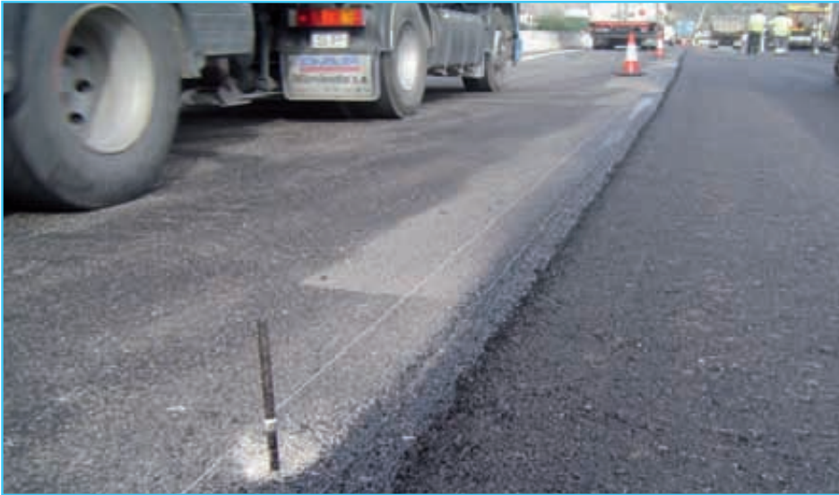
Foto 7. El extendido con cable da unos valores de IRI algo superiores al extendido con barras de larga referencia.
