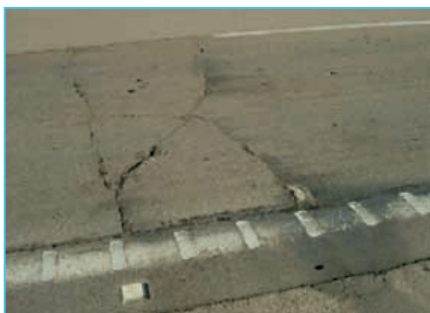
Foto 1. Detalle de firme fisurado antes y después del tratamiento con BMAP.
