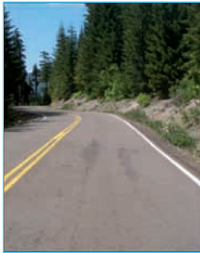
Foto 3. Fallos prematuros localizados debido a segregaciones térmicas.
