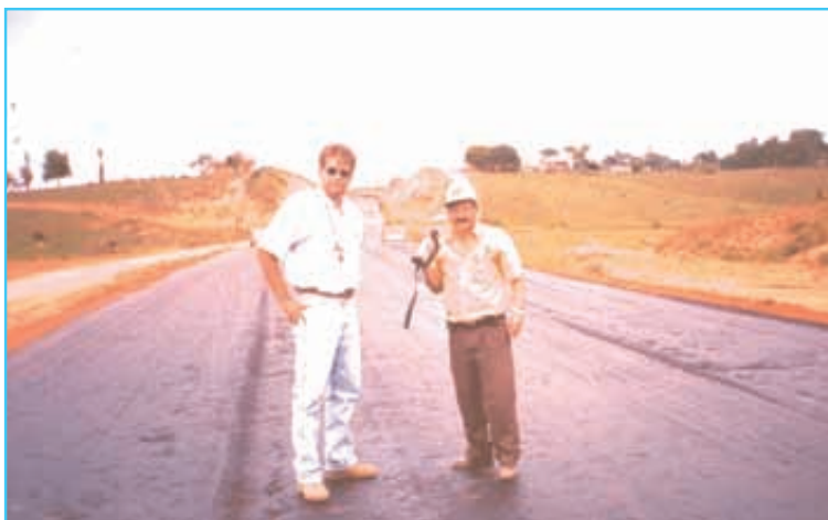
En las Imprimaciones Asfálticas de Bases Granulares estamos obligados a pasar del uso de los Rc ó Mc a las Emulsiones Asfálticas (lamentablemente la fotografía corresponde a una obra en ejecución en territorio Brasileiro y no en Perú como nos gustaría)
