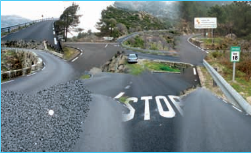
Foto 2. Diversos aspectos de una mezcla drenante semicaliente ejecutada en la provincia de Ávila.
