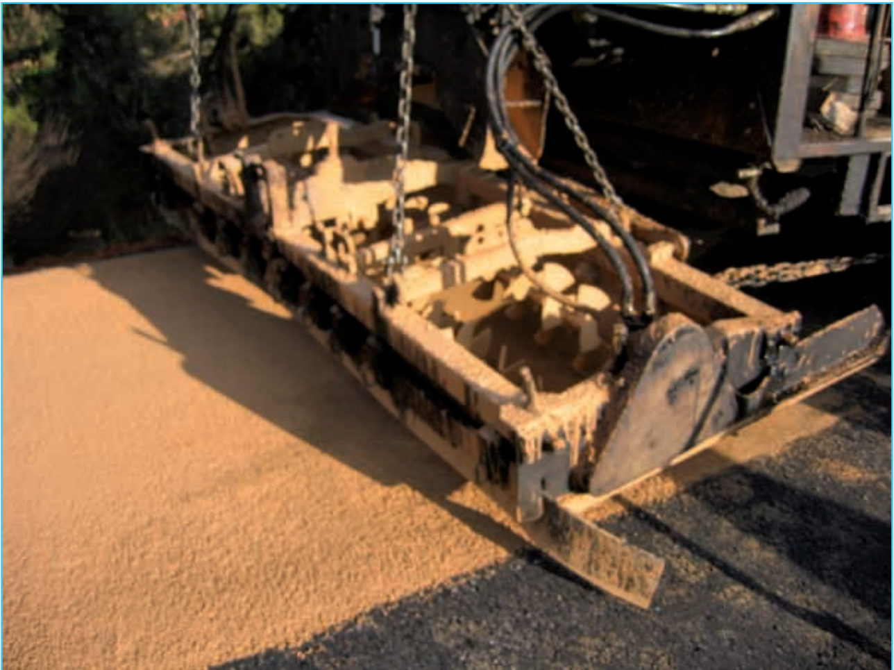
Foto 5. La fabricación y ejecución de las lechadas se realiza mediante equipos y técnicas convencionales.
