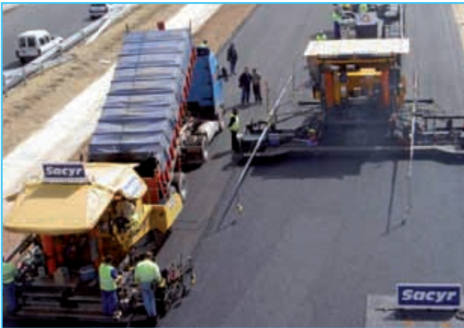
Foto 11. Disposición del extendido en paralelo con y sin equipo de transferencia de material (MTD). Detalle del funcionamiento del equipo MTD (derecha).
