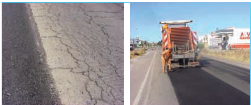
Foto 2. Pavimento antes y después de reciclar.
