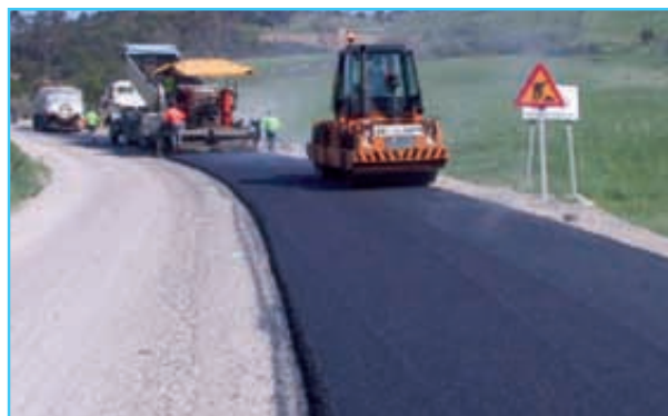
Foto 5. Fabricación a pie de planta y aplicación de una mezcla con un betún de alta viscosidad con caucho.
