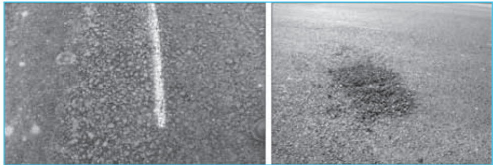
Foto 1. Segregaciones granulométricas visibles.
