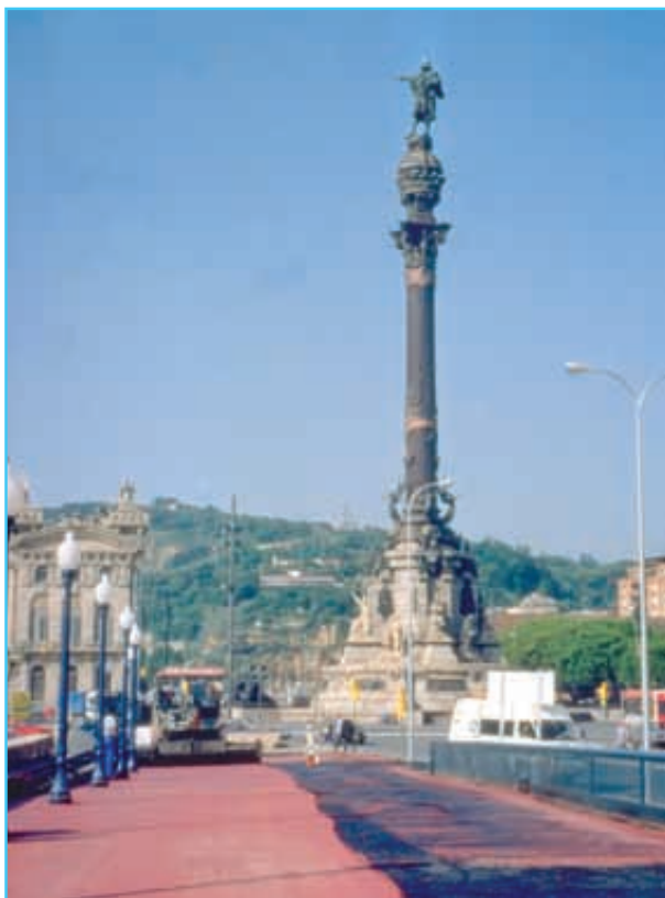
Foto 2. Ejecución de una lechada coloreada en la plaza de Colón de Barcelona.
