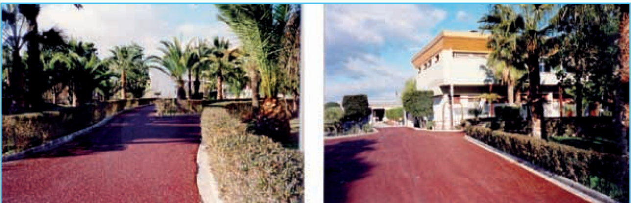
Foto 2. Pavimentación con mezclas asfálticas coloreadas.
