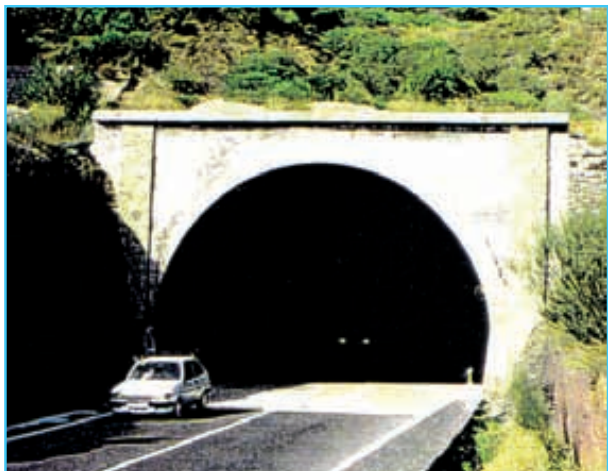
Foto 3. Túnel de Tuiro en la carretera N-630 León- Oviedo (España).
