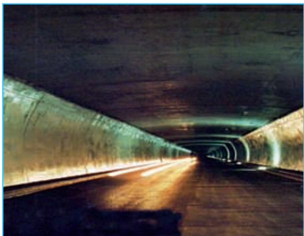
Foto 4. Aspecto interior del túnel de Somport.
