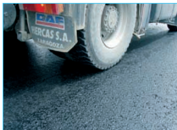
Foto 3. Detalle de riego con emulsión convencional (izquierda) y con emulsión termoadherente (derecha).
