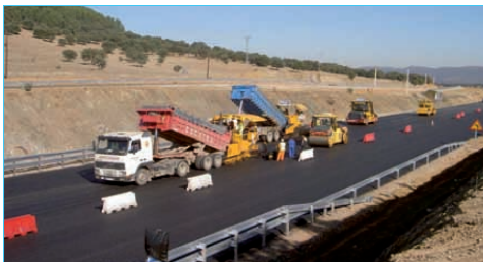
Foto 2. Aplicación de mezcla con betún multigrado. Tramo Zalea-Ardales.
