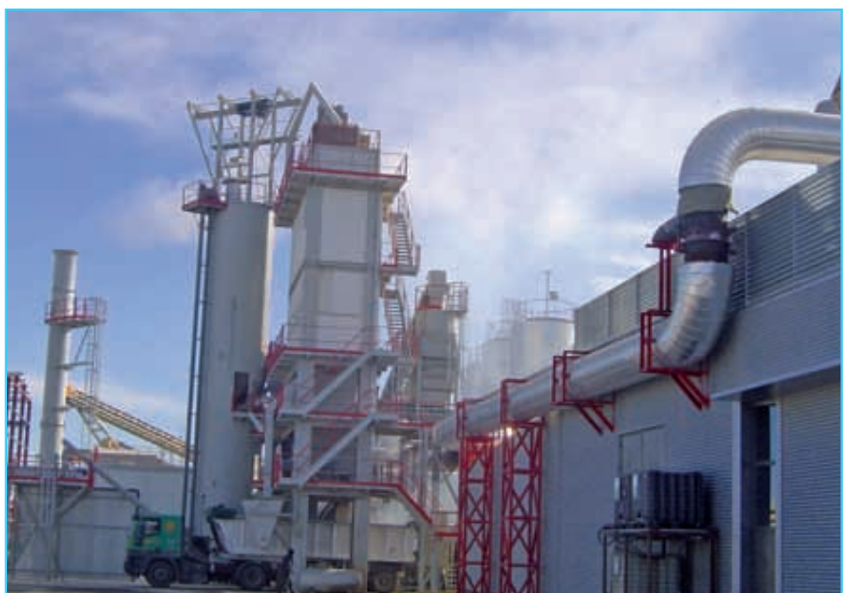
Foto 1. Planta de cogeneración y planta asfáltica en las instalaciones que SORIGUÉ, S.A. tiene en Balaguer (LLeida).
