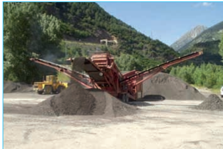
Foto 8. Cribado de los materiales obtenidos por fresado de firme, previo a su introducción en la central de fabricación. (CN-230, Valle de Arán, Lleida).
