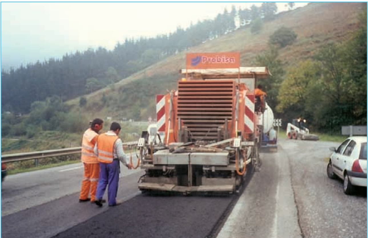
Foto 6. Recicladora con regla de compactación.
