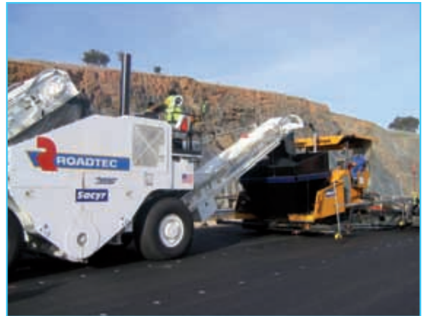
Foto 11. Disposición del extendido en paralelo con y sin equipo de transferencia de material (MTD). Detalle del funcionamiento del equipo MTD (derecha).
