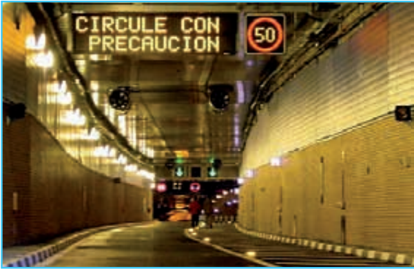
Foto 1. Vista de uno de los túneles de la M-30 construidos en Madrid.
