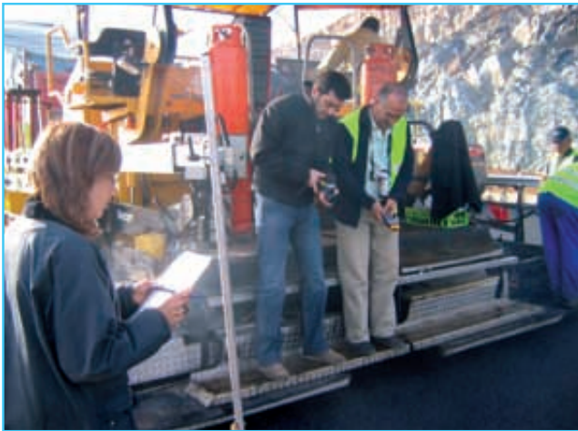
Foto 6. Trazado de perfil de temperaturas con termómetros de infrarrojos convencionales (izq) y con el sistema PAVE-IR desarrollado en Texas, EE.UU. (dcha).
