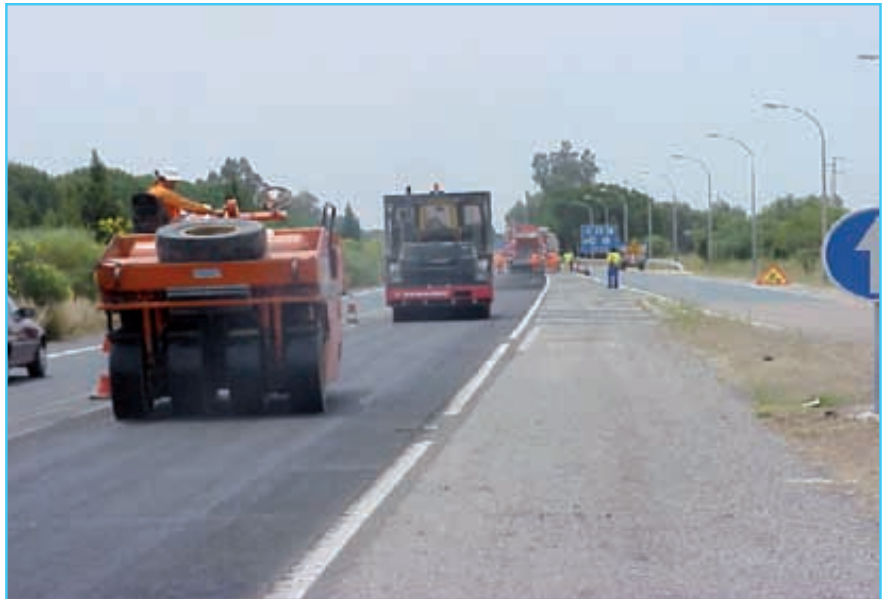
Foto 5. Proceso de compactación del reciclado.
