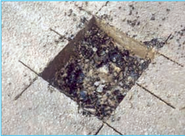
Foto 1. Calicata para extraer material.
