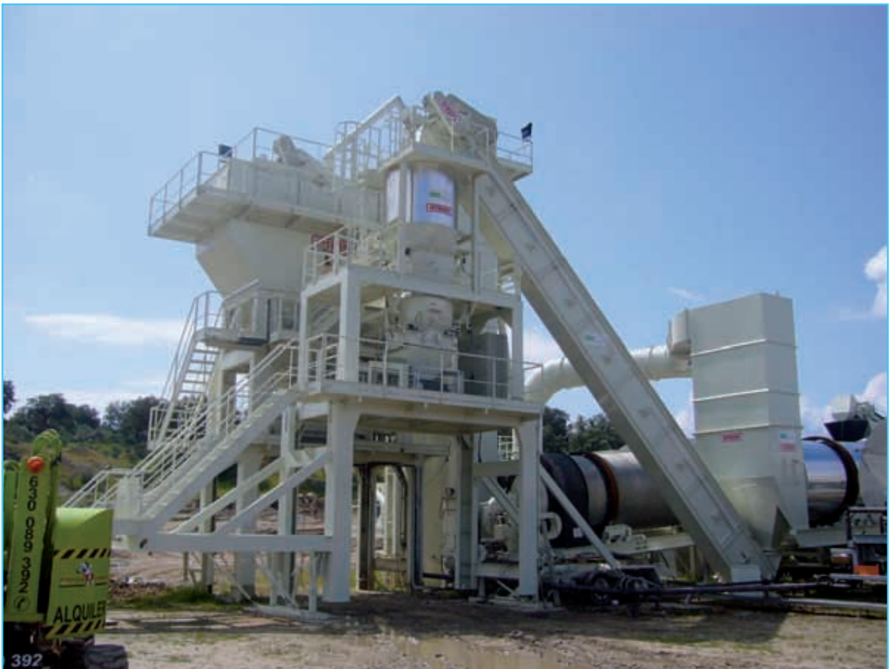
Foto 2. Integración del sistema de reciclado en una planta asfáltica UM-200: Integración de la torre de reciclado con la torre de la planta asfáltica.
