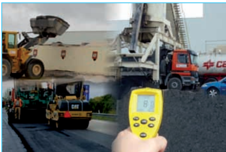
Foto 1. Diversos aspectos en la ejecución de un reciclado semicaliente.
